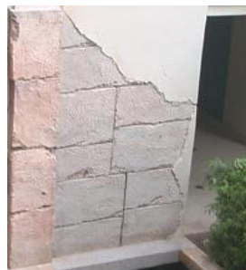
หลังจากใช้เครื่องเทอร์โบล้าง พร้อมปรับสภาพร่องสีใหม่
