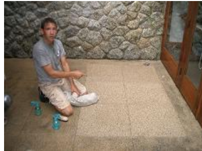
พื้นหินทรายหลังขัดล้างด้วยเครื่องเทอร์โบ
